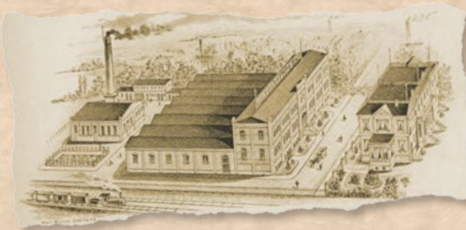
Unsere neue Fabrik in Schönau.
