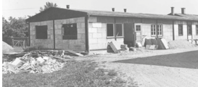
In dieser Baracke waren die ukrainischen Zwangsarbeiterinnen untergebracht. Das Foto entsteht bei ihrem Umbau 1950.
